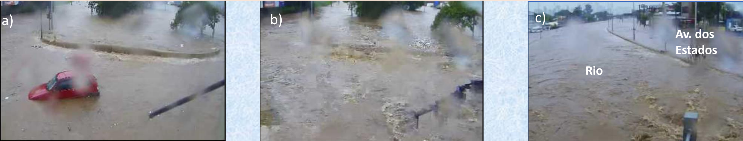
Figura 5 – Rio Tamanduateí, esquina da Rhodia com Av. dos Estados, o rio transbordando (a) e na figura 5b o mesmo local, não se diferenciando o rio e a Av. dos Estados. A Figura 5c mostra o Rio Tamanduateí transbordado, dia 31/03/2025.
